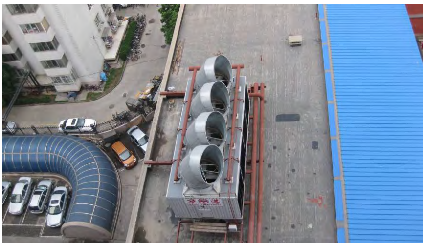
图 5.1-1 冷却塔导向消声器实施实例
