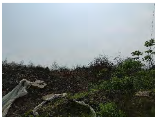
南浔变电所拟建所址西侧
