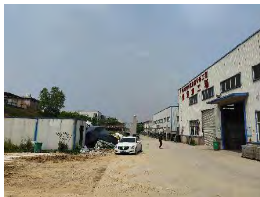
洪桥镇变电所拟建所址北侧
