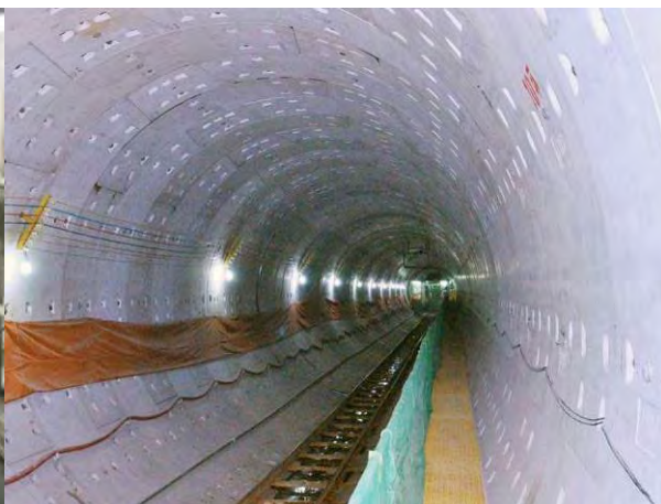
盾构法隧道施工现场（建成后）
