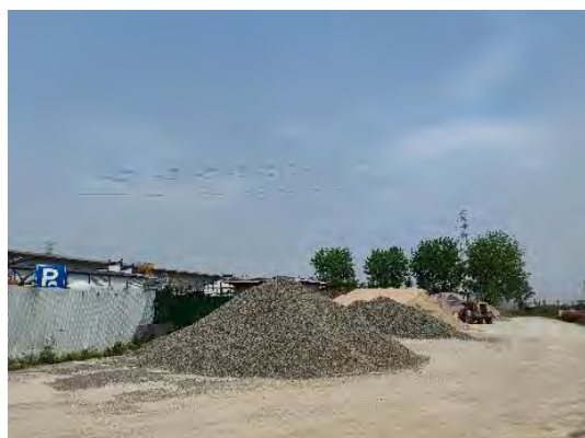
南浔变电所拟建所址东侧
