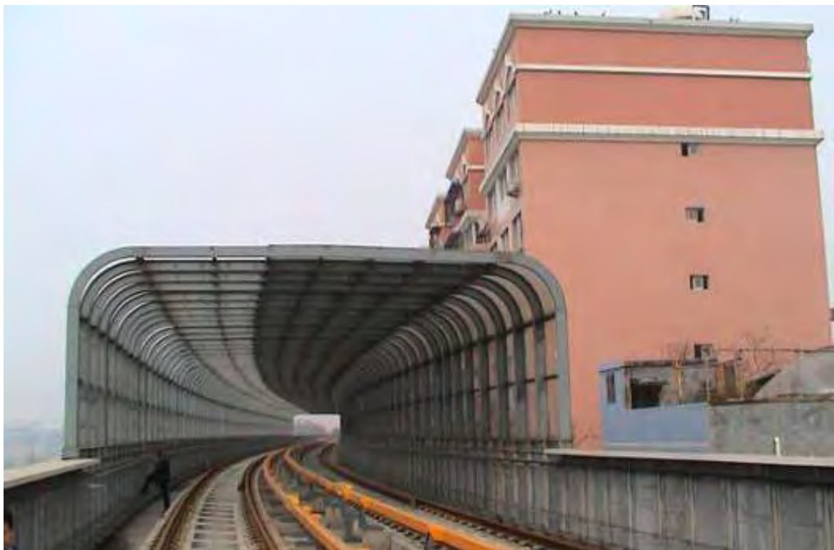
图 5.1-3 大型折板式（半封闭）声屏障示意图
