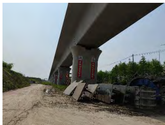
南浔变电所拟建所址北侧
