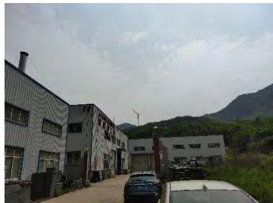
洪桥镇变电所拟建所址南侧
