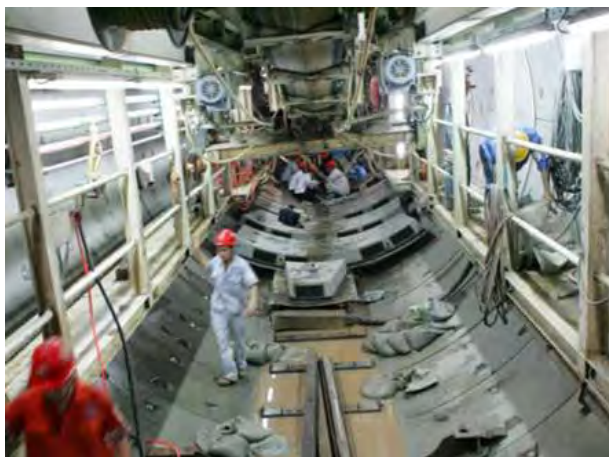
盾构法隧道内部施工现场
