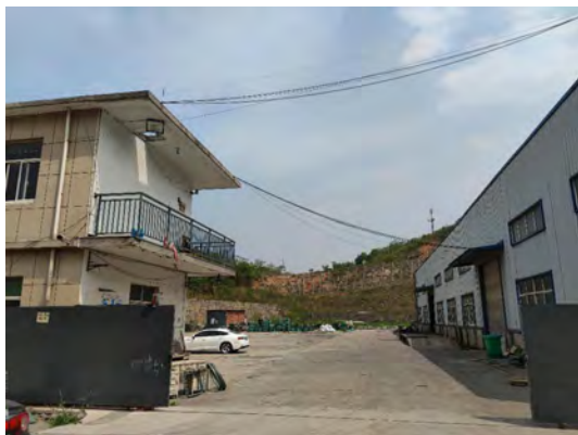
洪桥镇变电所拟建所址东侧
